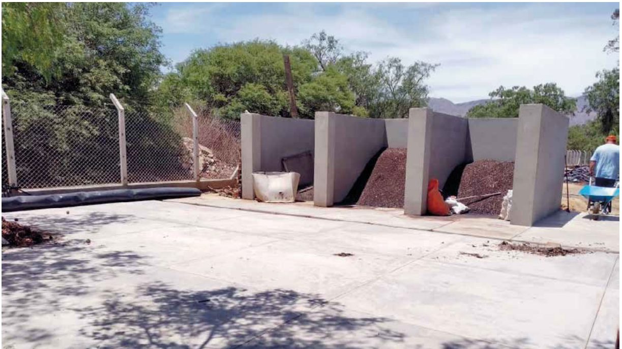
Almacenamiento de material tamizado
