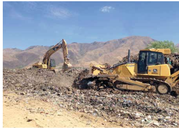
Movimiento de residuos con apoyo de maquinaria
