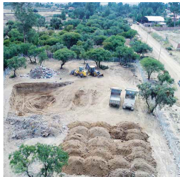
Impermeabilización con arcilla en zanja
