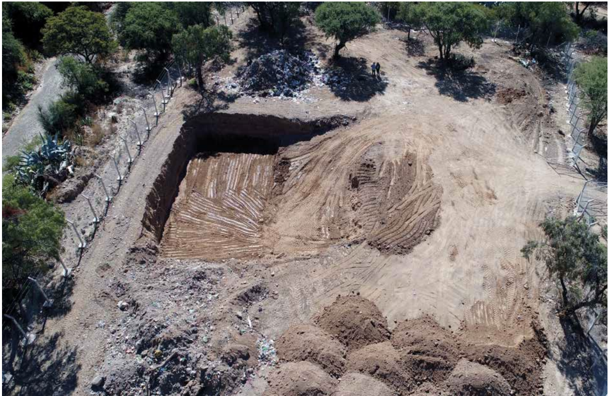
Zanja impermeabilizada con arcilla Botadero readecuado en el municipio de Arbioto
