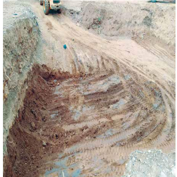
Compactación de arcilla dentro la zanja
