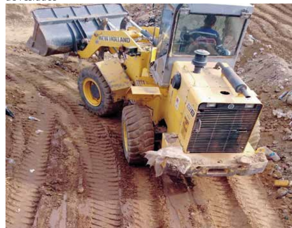
Apoyo de pala para la aplicación de material de impermeabilización
