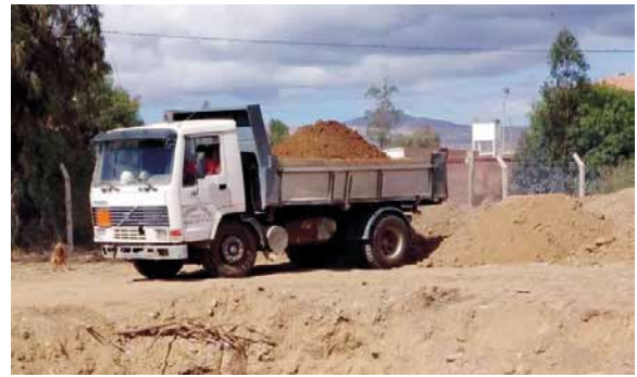
Vehículo de apoyo para el transporte de material de cobertura
