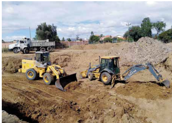
Aplicación de material para impermeabilización de la zanja
