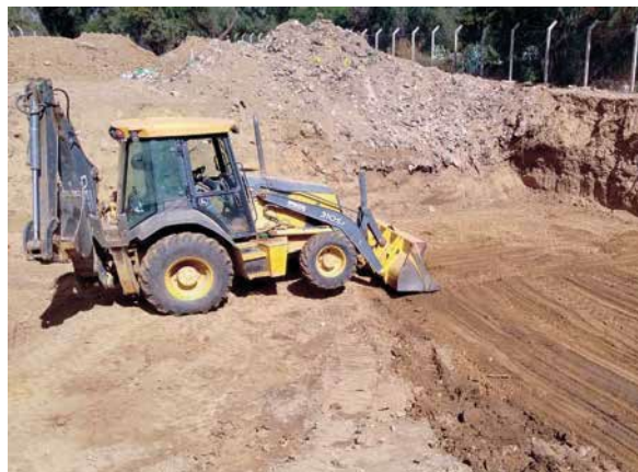
Maquinaria de apoyo para excavación de la zanja y movimiento de residuos
