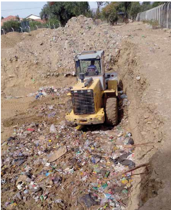
Maquinaria apoyando con el esparcimiento de residuos dentro de las zanjas
