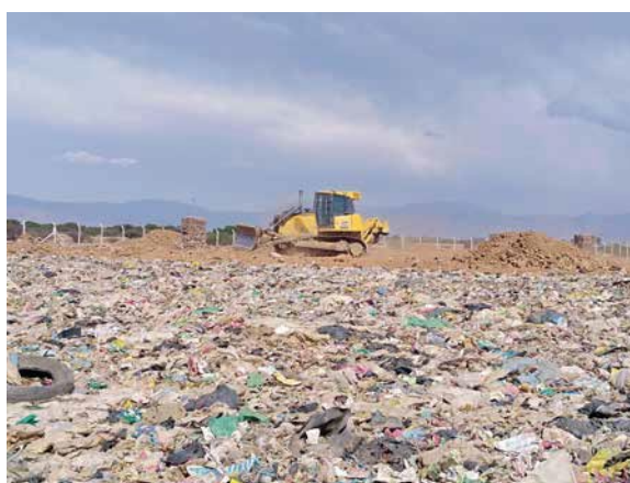
Aplicación de material de cobertura en la macrocelda para evitar el esparcimiento de los mismos por los vientos y así evitar la proliferación de moscas y otros vectores
