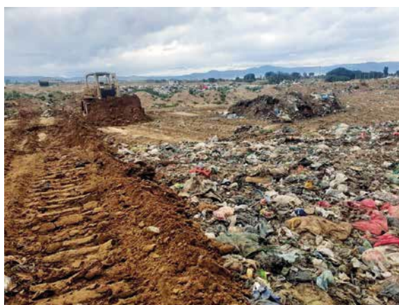
Aplicación de material de cobertura en la macrocelda para evitar el esparcimiento de los mismos por los vientos y así evitar la proliferación de moscas y otros vectores
