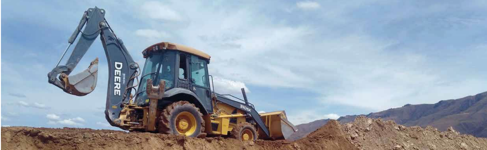
Movimiento de tierras para conformación de zanja
